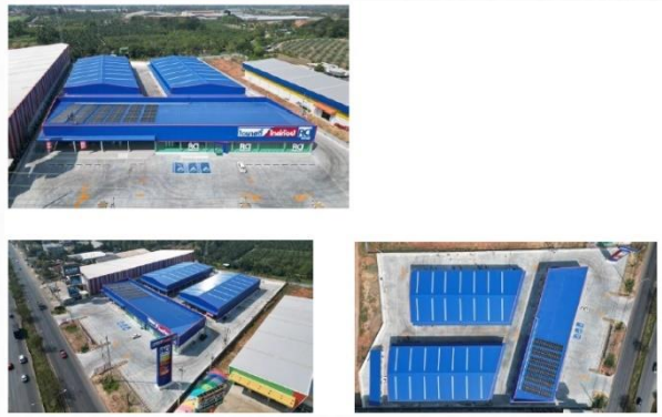
การติดตั้ง SOLAR CELL บนหลังคาของสาขา
